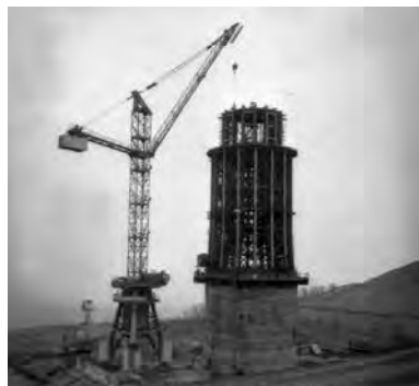
Строительство башни Кок-Тобе. Алматы, 1979 г.
